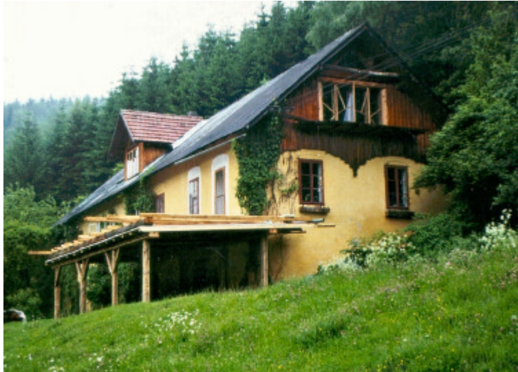
Abbildung 18: Wohngemeinschaft im Arbeiterwohnhaus einer ehemaligen Eisenmanufaktur
