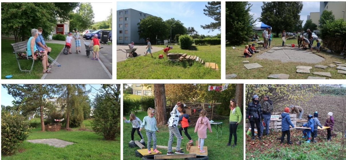
Bild 32 Modellvorhaben im Quartier Hohrainli in Kloten: Aktivitäten mit Kindern: Bau eines Natursteinplatzes mit wiederverwendeten Materialien. Heute stehen dort zwei Tische und Gartenstühle, die gern genutzt werden.
