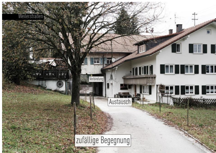
Das Foto zeigt ein Beispiel der Verschränkung von privatem und öffentlichem Raum. Eine öffentliche Wegeverbindung führt aus dem Weiler hinaus durch das Bauvolumen eines landwirtschaftlichen Gehöftes hindurch. © Schmölz 2018
